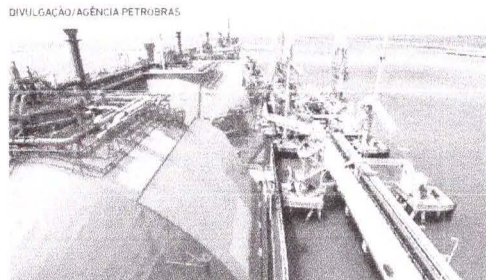
NAVIO de regaseificação de IGNL no Terminal do Pecém
